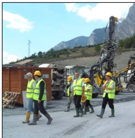
Sur un Chantier
